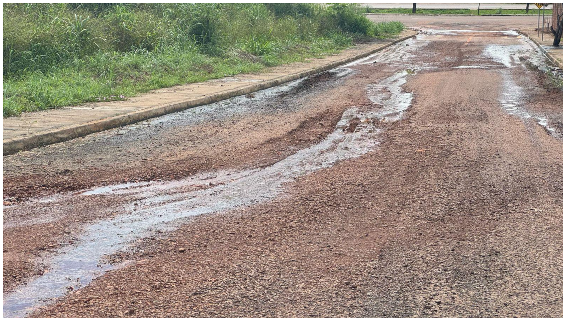
IMAGEM 1: RUA RECENTEMENTE ASFALTADA, APRESENTANDO SINAIS DE DETERIORAÇÃO DEVIDO A FALHAS NO SISTEMA DE DRENAGEM, OCASIONANDO O ESCOAMENTO INADEQUADO DE ÁGUA SOBRE A VIA.
