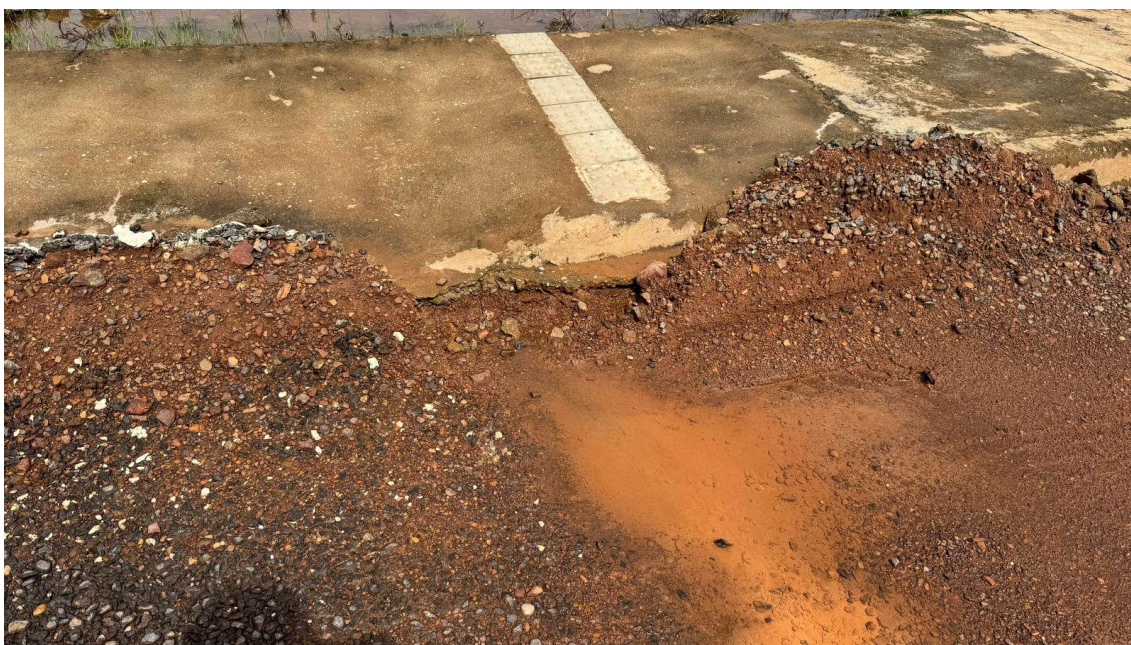
IMAGEM 4: RAMPA DE ACESSO À CALÇADA COMPLETAMENTE OBSTRUÍDA, EM RAZÃO DO AFUNDAMENTO DO ASFALTO PROVOCADO PELO ESCOAMENTO CONTÍNUO DAS MINAS D'ÁGUA SITUADAS NAS PROXIMIDADES DA VIA.
