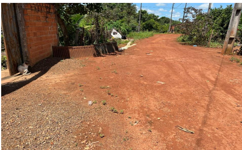
IMAGEM 03: Registro de barreira improvisada construída por morador na tentativa de impedir que a água da chuva adentre sua residência. A medida emergencial evidencia a gravidade do desnível da via e a ineficiência do sistema de drenagem pluvial.
