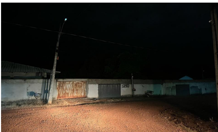
IMAGEM 06: Poste de iluminação pública com lâmpada queimada, localizado à esquerda da casa de número 1290. A ausência de iluminação compromete a segurança pública e a visibilidade no período noturno.
